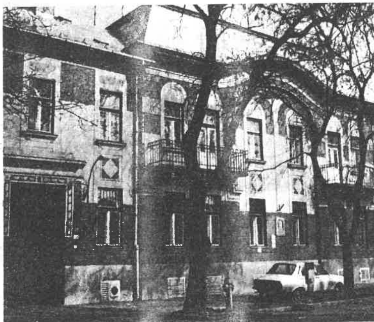
A nyíregyházi rádió épületében egykor magánszanatórium működött
