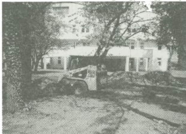
Az új kórházi épület mögötti részen erőgépekkel végezték el a tereprendezési munkálatok nagy részét a felkért szakemberek
